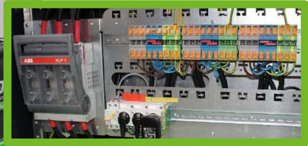
Vorgefertigter AC-Anschlussblock für eine schnelle und unkomplizierte Installation
